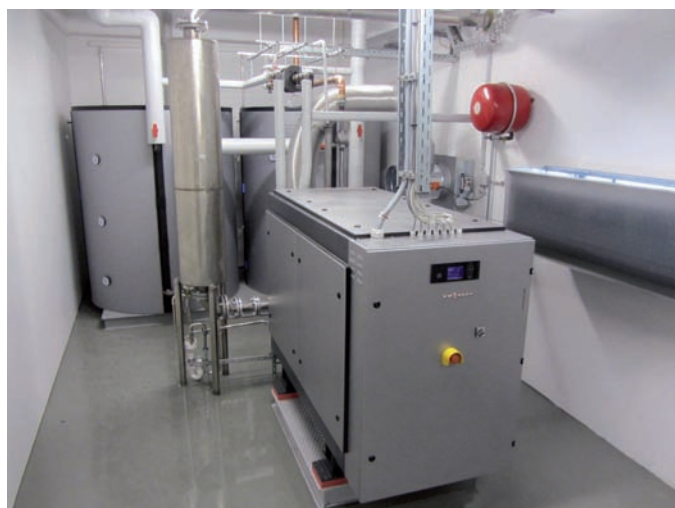
Exemple d'une centrale de cogénération Viessmann.
